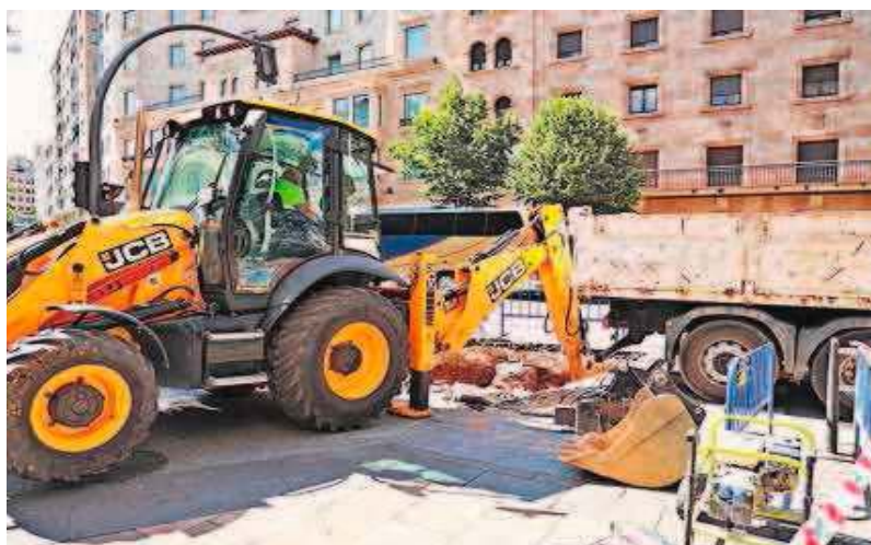
Los operarios de Aqualia revisan la incidencia del paseo de la Estación. OBES
